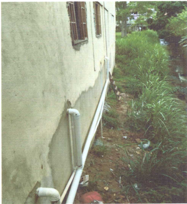
Instalação Esgoto externo na sede da guarda
