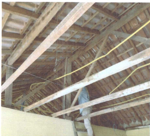
Início de engradamento para forro 2º Pavimento
