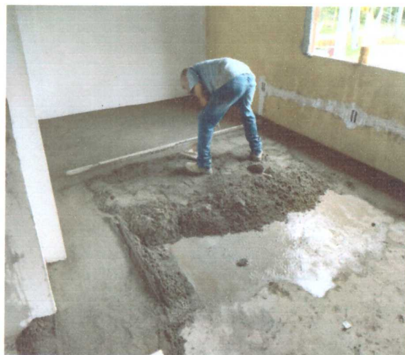
Início de contra piso no primeiro e segundo pavimento ( sede da guarda)
