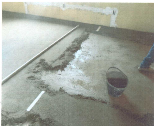
Início de contra piso no primeiro e segundo pavimento ( sede da guarda)
