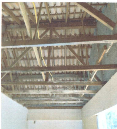
Início de engradamento para forro 2º Pavimento
