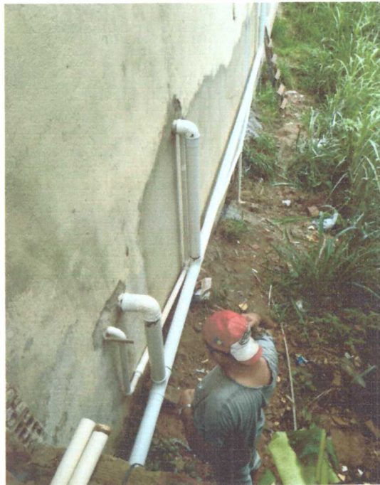
Instalação Esgoto externo na sede da guarda
